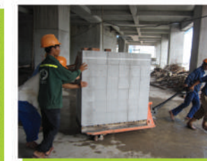
Kéo chuyển gạch trên sàn thi công
