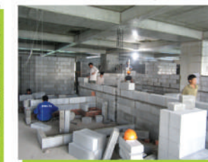
Xây hoàn thiện tường gạch
