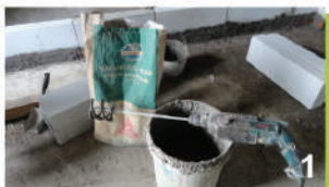
1 Dùng cánh khuấy lắp vào máy khoan cầm tay để trộn vữa
