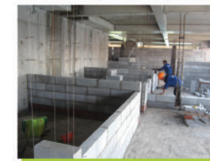
Xây thân tường bằng vữa xây SCL-MORTAR
