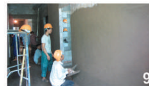
9 Trát tường hoàn thiện
