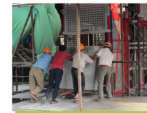
Chuyển gạch lên tầng xây bằng vận thẳng
