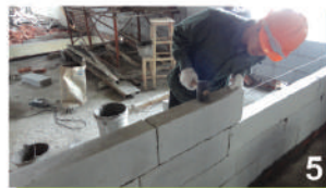
5 Căn chỉnh gạch bằng búa cao su
