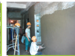
Trát tường bằng vữa trát SCL-MORTAR
