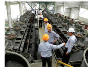
Hệ thống máy tuyển tro bay
